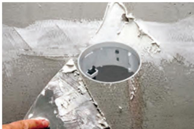
**3. Appliquez sur le panneau la couche de plâtre nécessaire** – en prenant bien soin de recouvrir la partie intégrée du dispositif.
