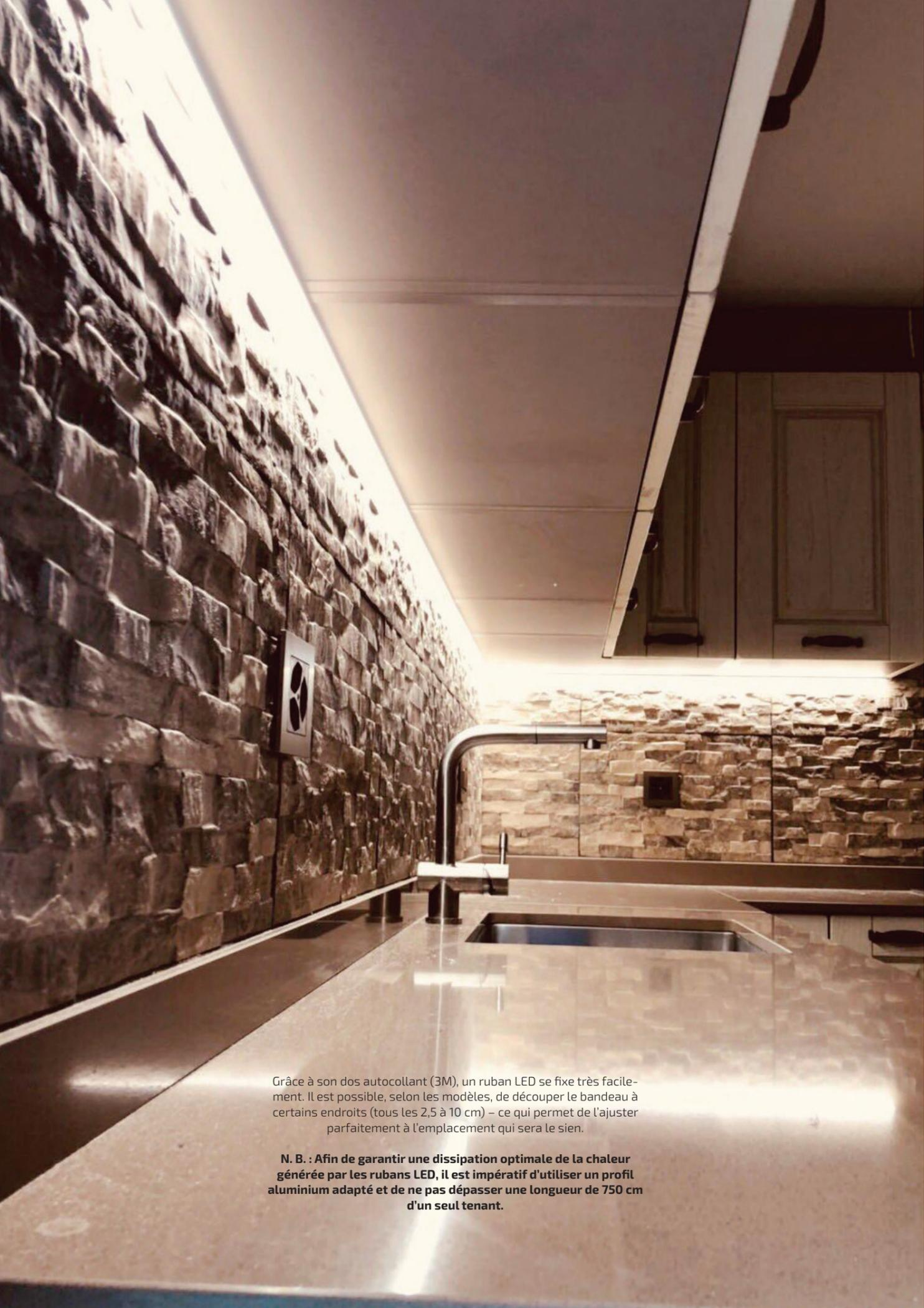
Grâce à son dos autocollant (3M), un ruban LED se fixe très facilement. Il est possible, selon les modèles, de découper le bandeau à certains endroits (tous les 2,5 à 10 cm) – ce qui permet de l'ajuster parfaitement à l'emplacement qui sera le sien.
