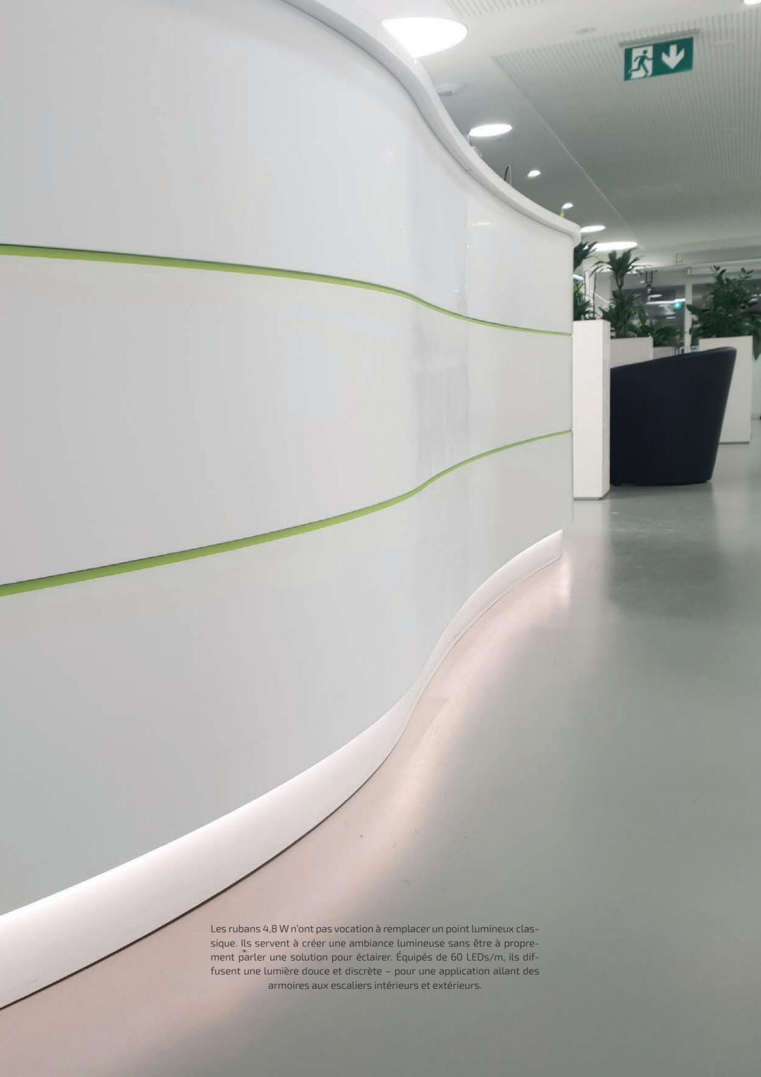
Les rubans 4,8 W n'ont pas vocation à remplacer un point lumineux classique. Ils servent à créer une ambiance lumineuse sans être à proprement parler une solution pour éclairer. Équipés de 60 LEDs/m, ils diffusent une lumière douce et discrète – pour une application allant des armoires aux escaliers intérieurs et extérieurs.
