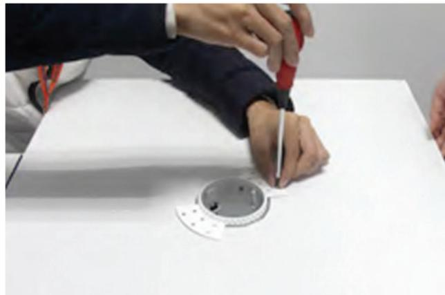
**2. Fixez la collerette au panneau** (possibilité de réglage de la hauteur de finition de 1 à 17,5 mm).
