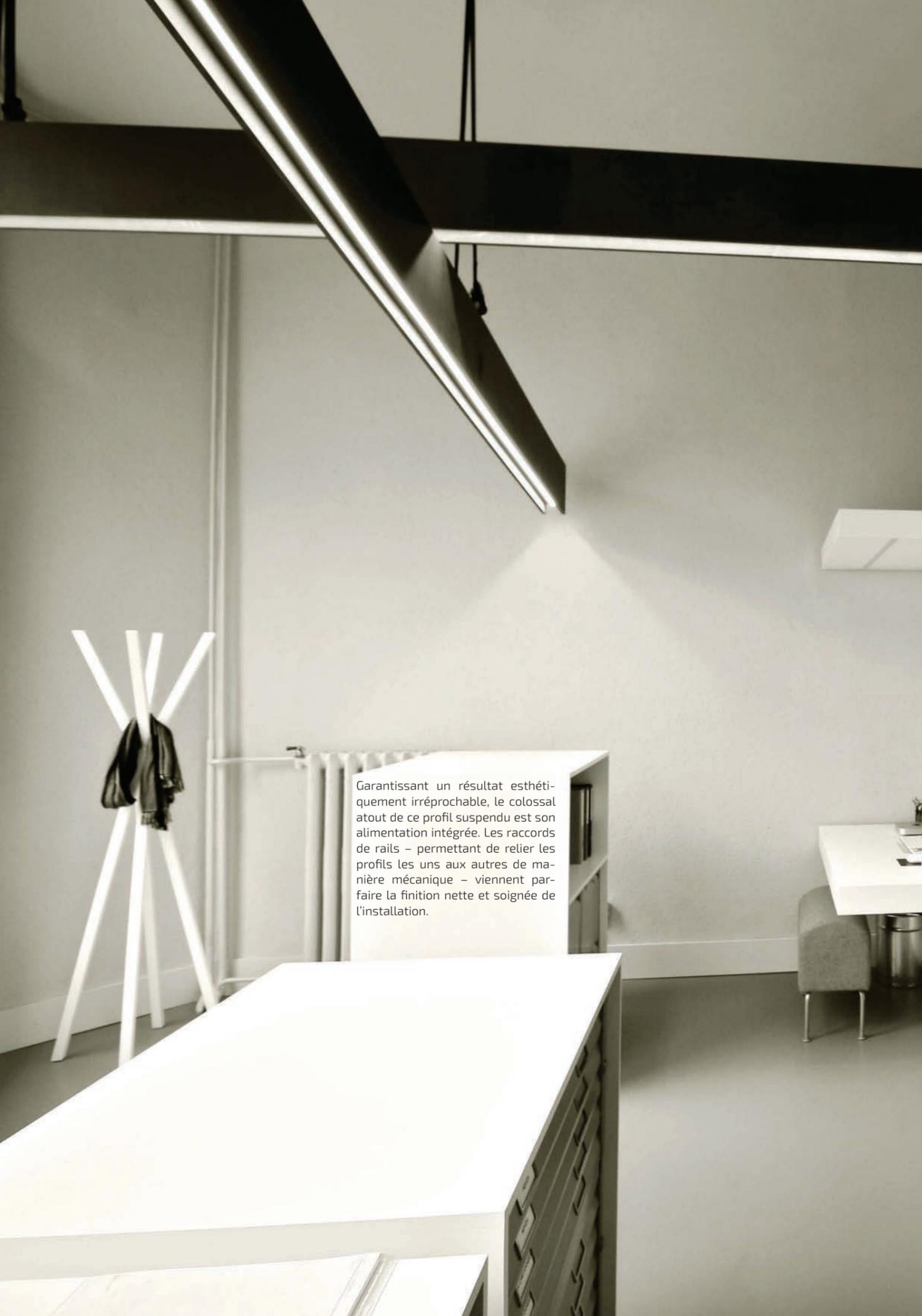
Garantissant un résultat esthétiquement irréprochable, le colossal atout de ce profil suspendu est son alimentation intégrée. Les raccords de rails – permettant de relier les profils les uns aux autres de manière mécanique – viennent parfaire la finition nette et soignée de l'installation.
